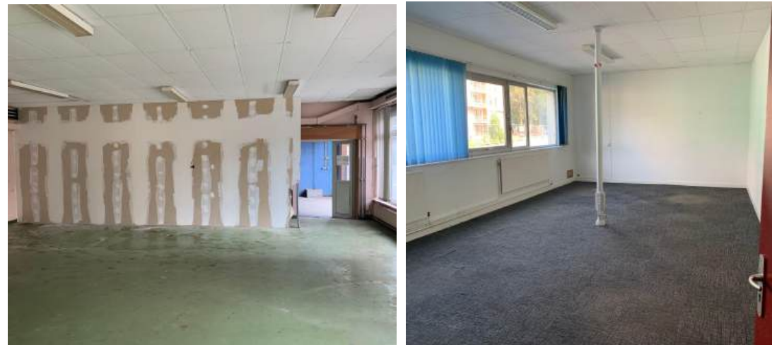
photos avant nettoyage du bâtiment
