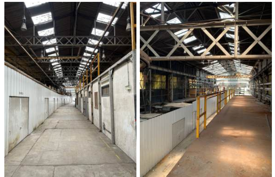
photos avant nettoyage du bâtiment
